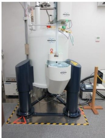
Fig.3 新機マグネット部 (立入制限テープ設置)
