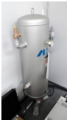
Fig.7 未固定タンク (床はカーペット敷)
