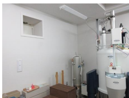
Fig.1 緊急時換気窓設置
