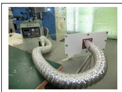
図 5-3 ホースの固定(全体)
